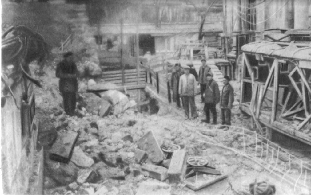
Разрушен вход на городской КП
